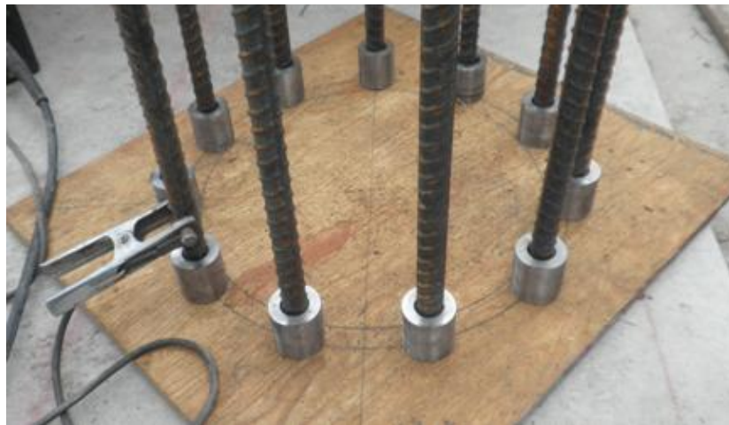
Figure 3-20 Longitudinal reinforcing bar template
